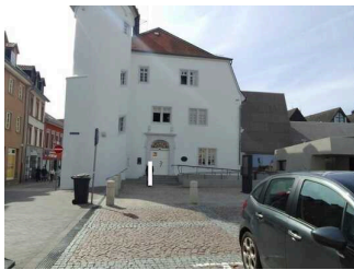
Weg über den Vorplatz (nicht erschütterungsarm)
