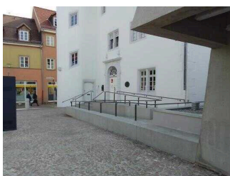
Treppe im Eingangsbereich
