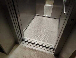
Aufzug von der Tiefgarage zum Vorplatz
