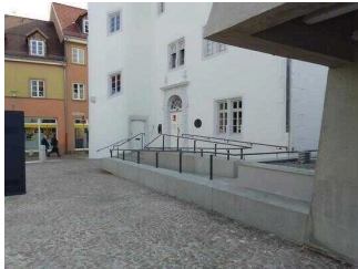
Treppe im Eingangsbereich
