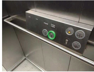
Aufzug von der Tiefgarage zum Vorplatz
