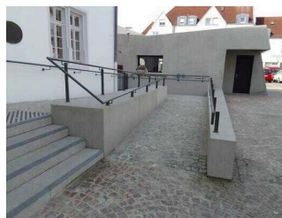
Rampe im Eingangsbereich
