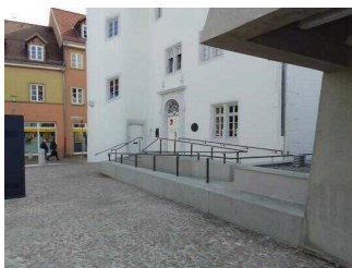
Rampe im Eingangsbereich
