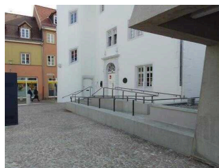
Weg über den Vorplatz
