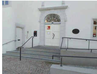
Treppe im Eingangsbereich
