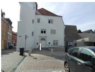
Weg über den Vorplatz (nicht erschütterungsarm)
